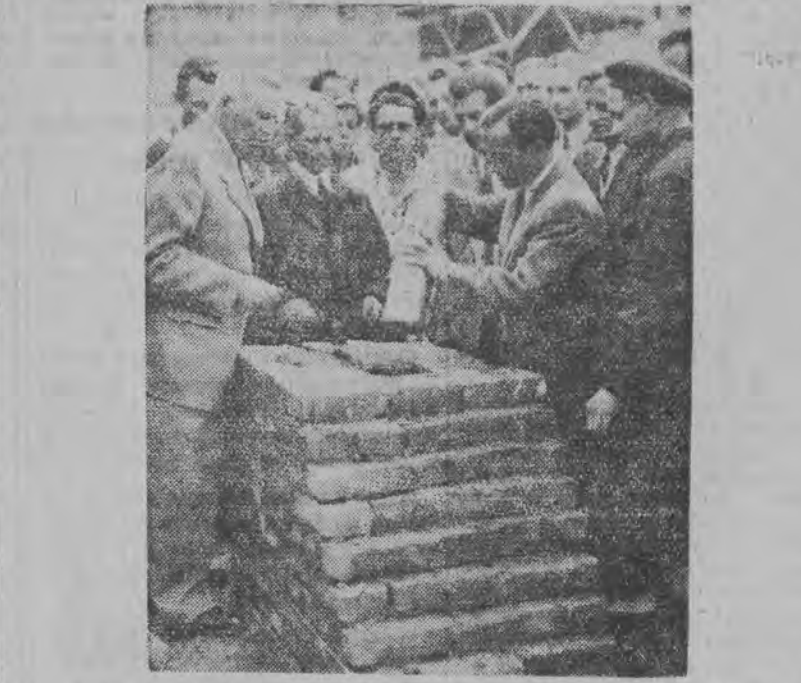
Dnia 16 bm. nastąpiło uroczyste wmurowanie aktu erekcyjnego pod budowę Marszałkowskiej Dzielnicy Mieszkanowej w Warszawie. Na zdję.: Przewodniczący Stołecznej Rady Narodowej, tow. J. Albrecht składa akt erekcyjny w fundamencie bloku 6-B MDM.
