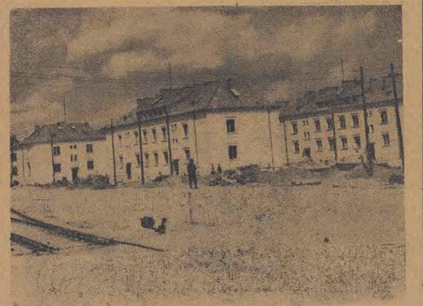
Oddane już do użytku nowe domy mieszkalne w Nowej Hucie. (fot. Jarochoński).
