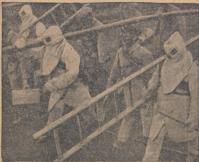
śpieszy z drabinami do częściowo zniszczonego gmachu.
