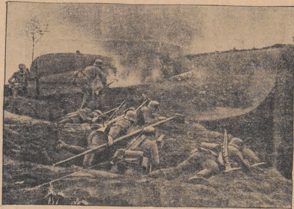
Atak saperów na betonowe umocnienia polowe.
