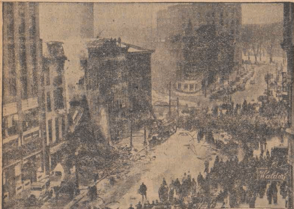
Trzystu strażaków przybyło by wyratować z płonącego domu, odciętych przez zawalenie się muru frontowego ośmiu toporników.
