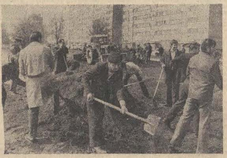
Prace na ul. Letniej
