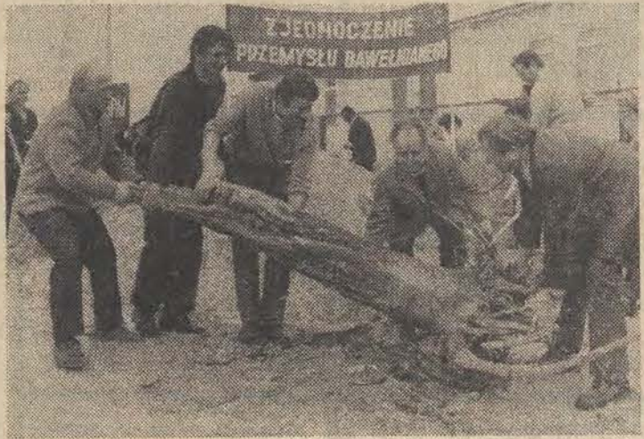
Na budowie EC-IV
