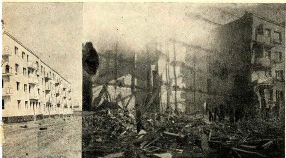
przewodników gazowych w budynku Związku Ubezpieczeń Prac. Umysłowych ni. Budynek przed eksplozją i po wybuchu.
