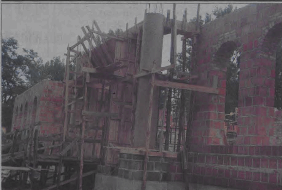
Coraz wyższe są mury powstającego w Alejkach Sienkiewicza („przed okrągłakiem”) budynku dydaktycznego Mazowieckiej Wyższej Szkoły Humanistyczno - Pedagogicznej w Łowiczu. Gmach ma być oddany do użytku przed rokiem akademickim 2001/2002. Ogólna powierzchnia budynku ma wynosić 2310 m 2 . Wewnątrz będą między innymi dwie duże aule wykładowe, mogące pomieścić jednorazowo 250 i 200 studentów. Ogółem 15 sal wykładowych w tym budynku będzie mogło jednorazowo pomieścić około 1100 studentów. (mak)
