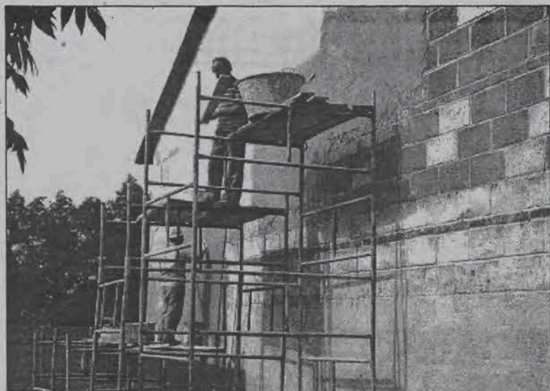
Dom Ludowy w Zielkowicach najpierw zostanie otynkowany, a potem wyremontowane zostanie poddasze
