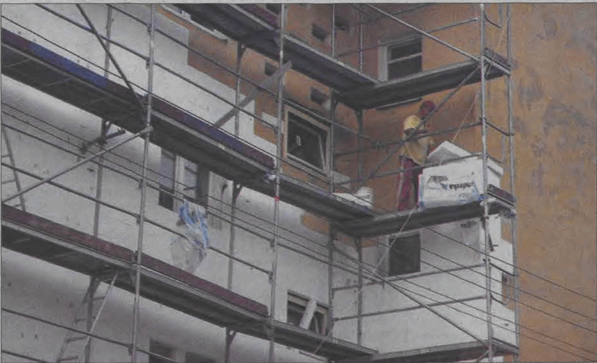
Blok numer 4 na osiedlu Tkaczew w Łowiczu jako ostatni w tym roku zostanie kompleksowo ocieplony. Prace na zlecenie Łowickiej Spółdzielni Mieszkaniowej trwają już od ponad tygodnia i mają zakończyć się w połowie października tego roku. Ocieplenie jest wykonywane metodą „lekką-mokrą”. Najpierw układana jest warstwa styropianu ze specjalną siatką, a na to dopiero warstwa lekkiego tynku. (mak)
