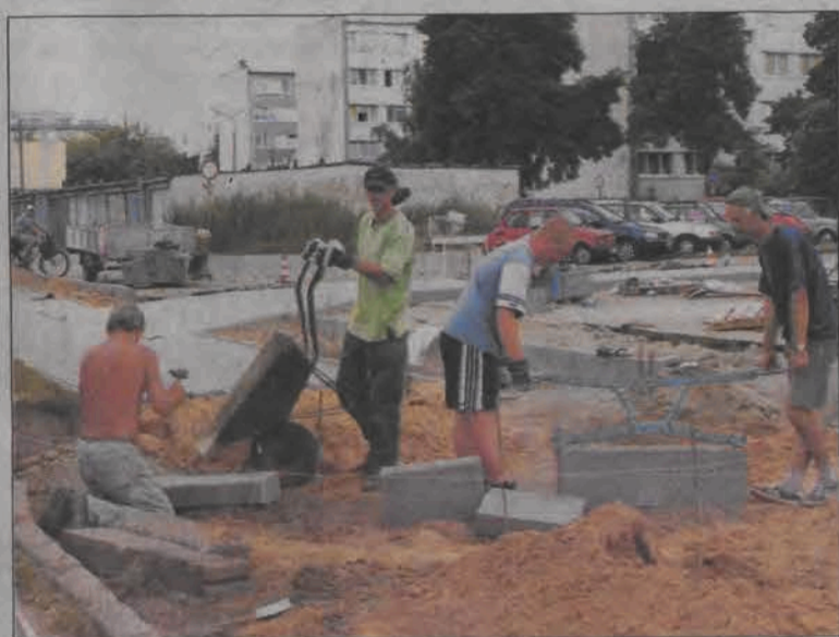
Miejmy nadzieję, że mieszkańcy Starzyńskiego będą korzystali z powstającego przejścia dla pieszych i nie będą przechodzili kilka metrów obok.
