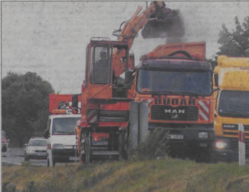
Zbieranie poboczy na „Dwójce” potrwa do połowy sierpnia, potem należy spodziewać się poważniejszych utrudnień w ruchu - rozpocznie się frezowanie i układanie nowej nawierzchni.
