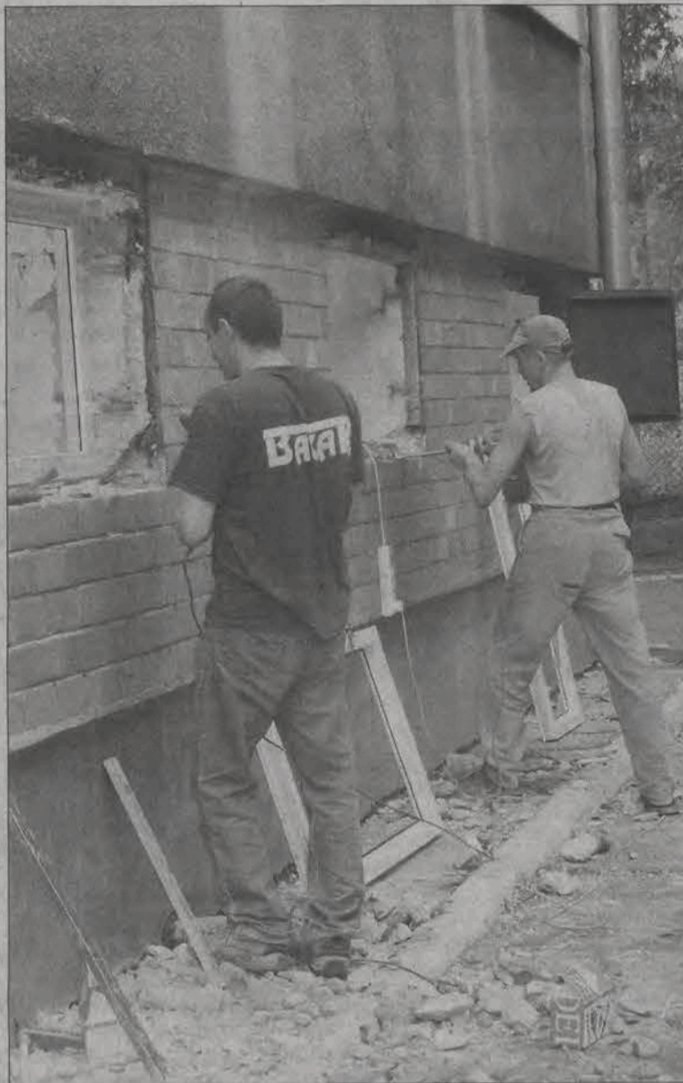
Wymiana wszystkich 146 okien oraz 4 drzwi w gimnazjum nr 1 potrwa do końca sierpnia.
