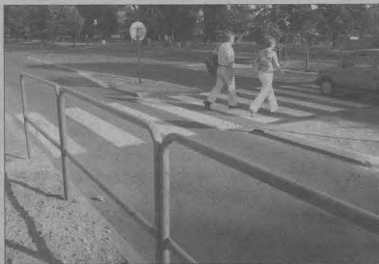
Barierki przy nowym przejściu przez ulicę Starzyńskiego już zostały zamontowane.
