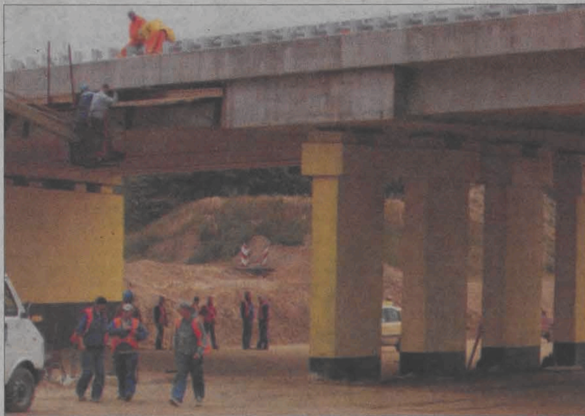
Przy budowie wiaduktów pracowało około 30 osób z firmy Mosty-Łódź.
