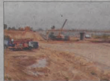
Widok z jeszcze niedokończonego wiaduktu, którym przebiegać ma trasa nr 14 na wiadukt, który ma być częścią węzła autostradowego.
