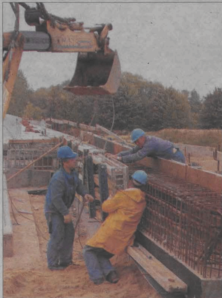
Prace przy wiadukcie, którym poleci „czternastka”.
