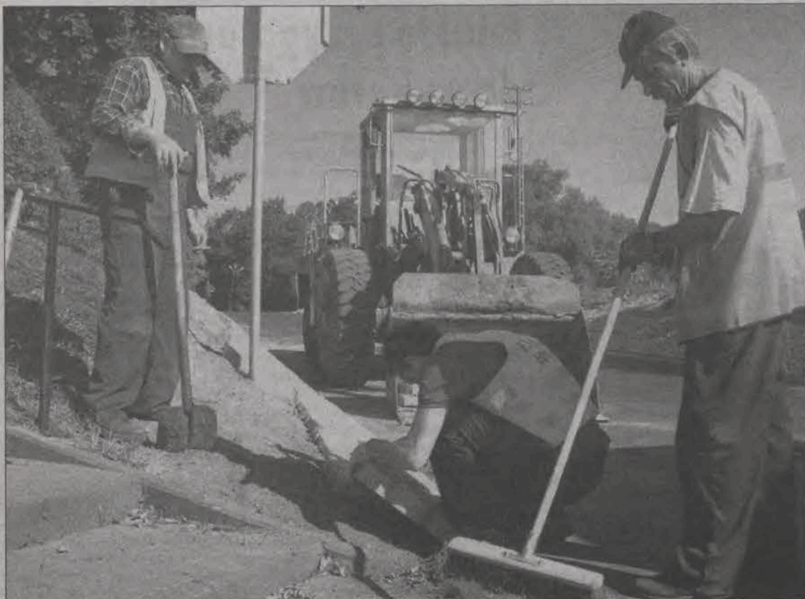
DROGA NA SKARATKI SKOŃCZONA. We wtorek, 30 sierpnia Przedsiębiorstwo Robót Inżynieryjno-Drogowych z Łowicza zakończyło modernizację drogi z Domaniewic w kierunku Skaratek. Ostatnie prace prowadzone były przy układaniu poboczy po obu stronach drogi na długości 300 m przy skrzyżowaniu z trasą nr 14, tuż przed kościołem. Odcinek 700 m został zmodernizowany nieco dalej w Skaratkach, od domu ludowego do Lisiewicz. Droga została poszerzona o około 40 cm z obu stron. Koszt inwestycji powiatowej to blisko 230 tys. zł. (eb)
