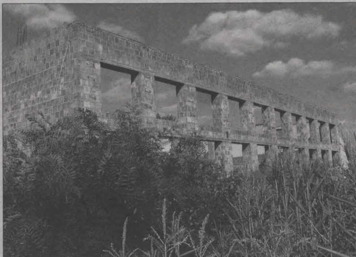
Wykonawca już rozpoczął prace w Łaguszewie, choć po murach na razie tego nie widać. Sala ma być gotowa do 20 grudnia.
