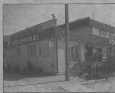
Własność gruntu pod tym budynkiem w centrum Domaniewic została podzielona pomiędzy gminę, pocztę, telekomunikację oraz bank.
