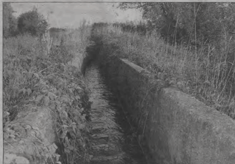
Kanał, którym oczyszczone ścieki płyną z oczyszczalni na stawy stabilizacyjne, w ostatnich dniach wypełniony był tylko w połowie oczyszczoną wodą.
