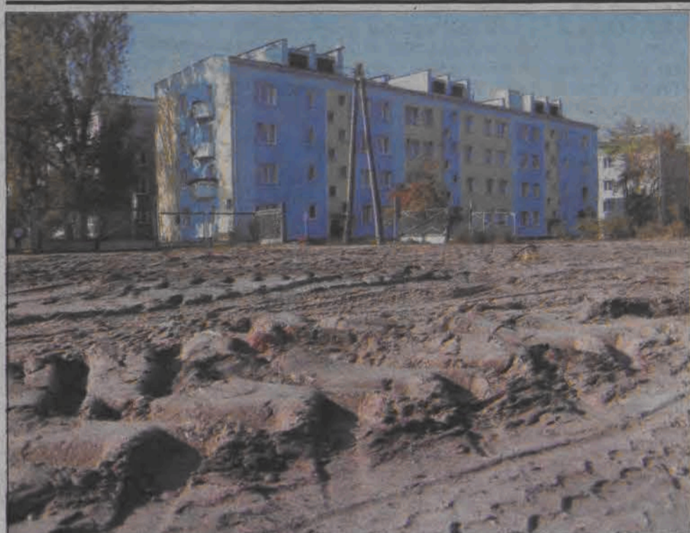
Po budynku dawnej hurtowni Promyk nie ma śladu, teren jest już wyrównany nawiezioną tam ziemią.
