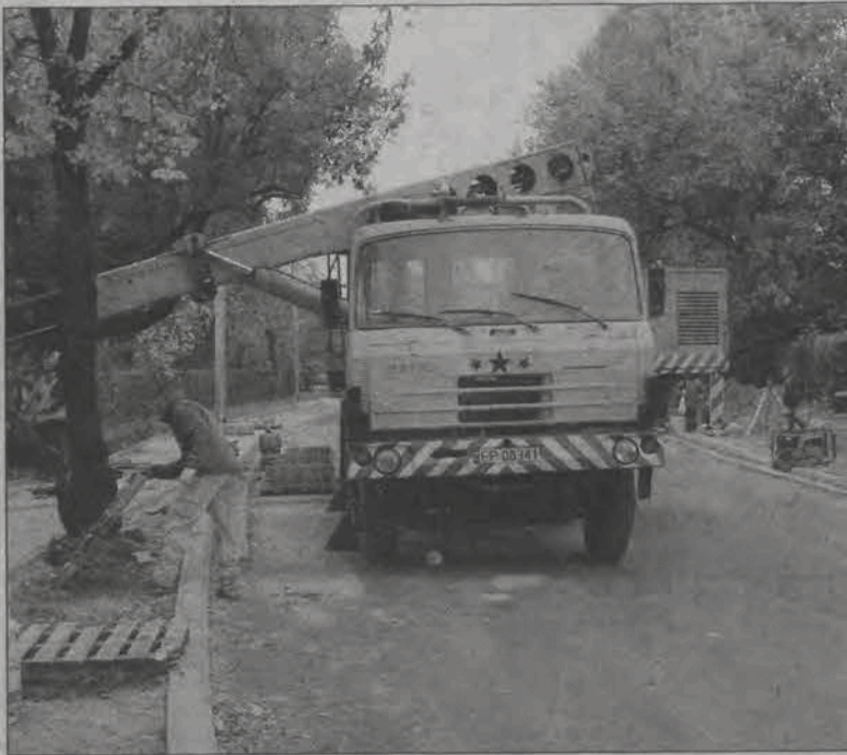
Na Bolimowskiej położono już dwie warstwy asfaltu. Na początku tygodnia trwały prace przy układaniu chodników.
