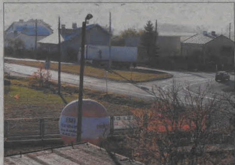
Obecny wygląd skrzyżowania. Bez jego modernizacji, a po wybudowaniu dwóch innych, przewidywanych ulic, stałoby się ono najbardziej niebezpiecznym skrzyżowaniem w Łowiczu.
