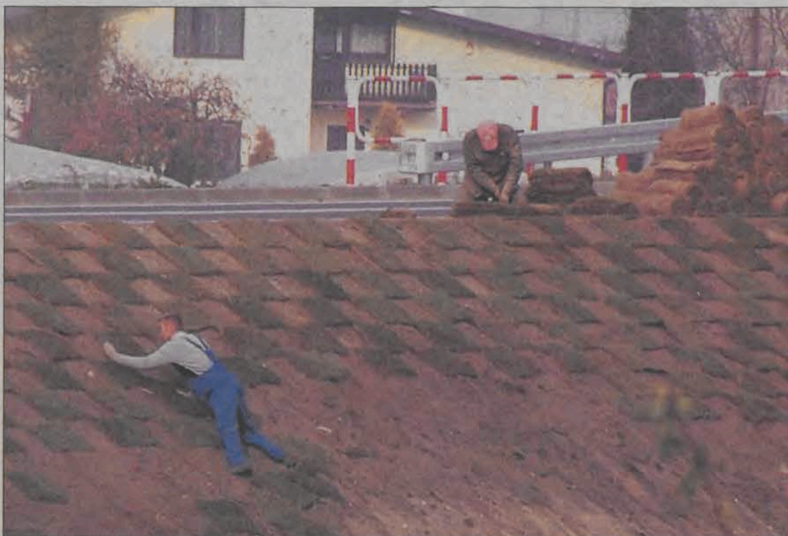
SZACHOWNICA NA POBOCZACH WARSZAWSKIEJ. Ciekawie prezentują się dosyć strome pobocza wyremontowanej ulicy Warszawskiej. Począwszy od ul. M. Konopnickiej do mostu zdobi je trawa ułożona w kształcie szachownicy. Osiągnięto dzięki temu nie tylko efekt wzmocnienia osypującej się ziemi z pobocza, ale również estetyczny. Równe kwadraty zielonej murawy zastąpiły różnej maści chwasty. (eb)
