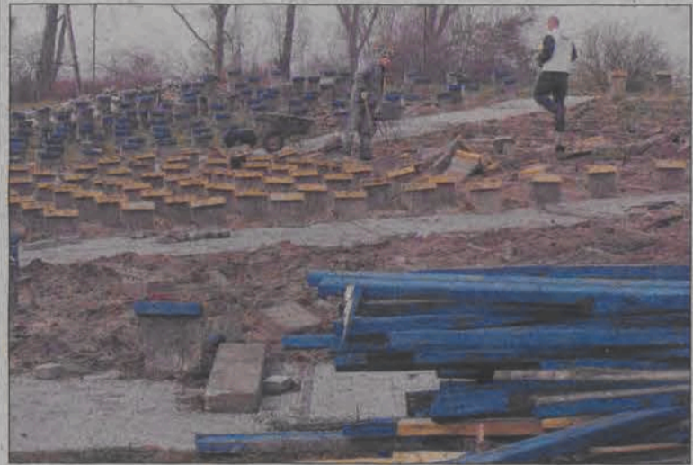
Prace na muszli rozpoczęły się od demontażu ławek na trybunach.
