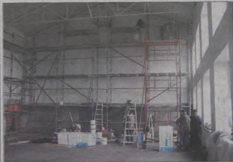
Wewnątrz sali gimnastycznej w Łaguszewie rozpoczęto już malowanie. Dwa odcienie koloru oliwkowego połączone będą z białą.
