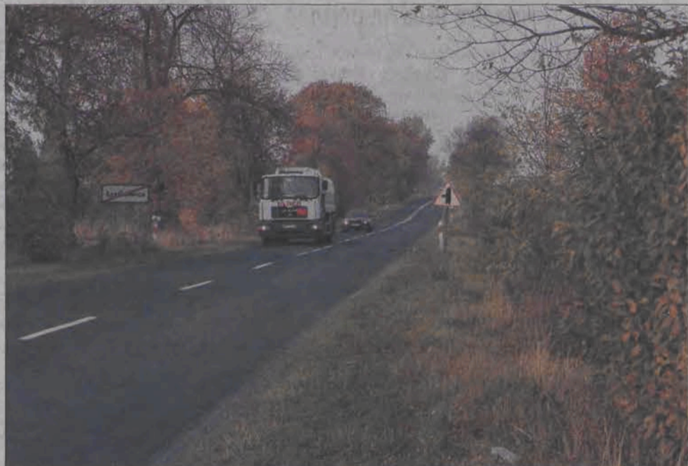
Droga z Łowicza do Brzezin przez Łyszkowice. Ona będzie jednym z dwóch głównych na naszym terenie traktów, wprowadzających na autostradę, bo prowadzącym do węzła „Łyszkowice”. Drugim będzie szosa z Łowicza do Skiemiewic, prowadząca do węzła „Nieborów”
