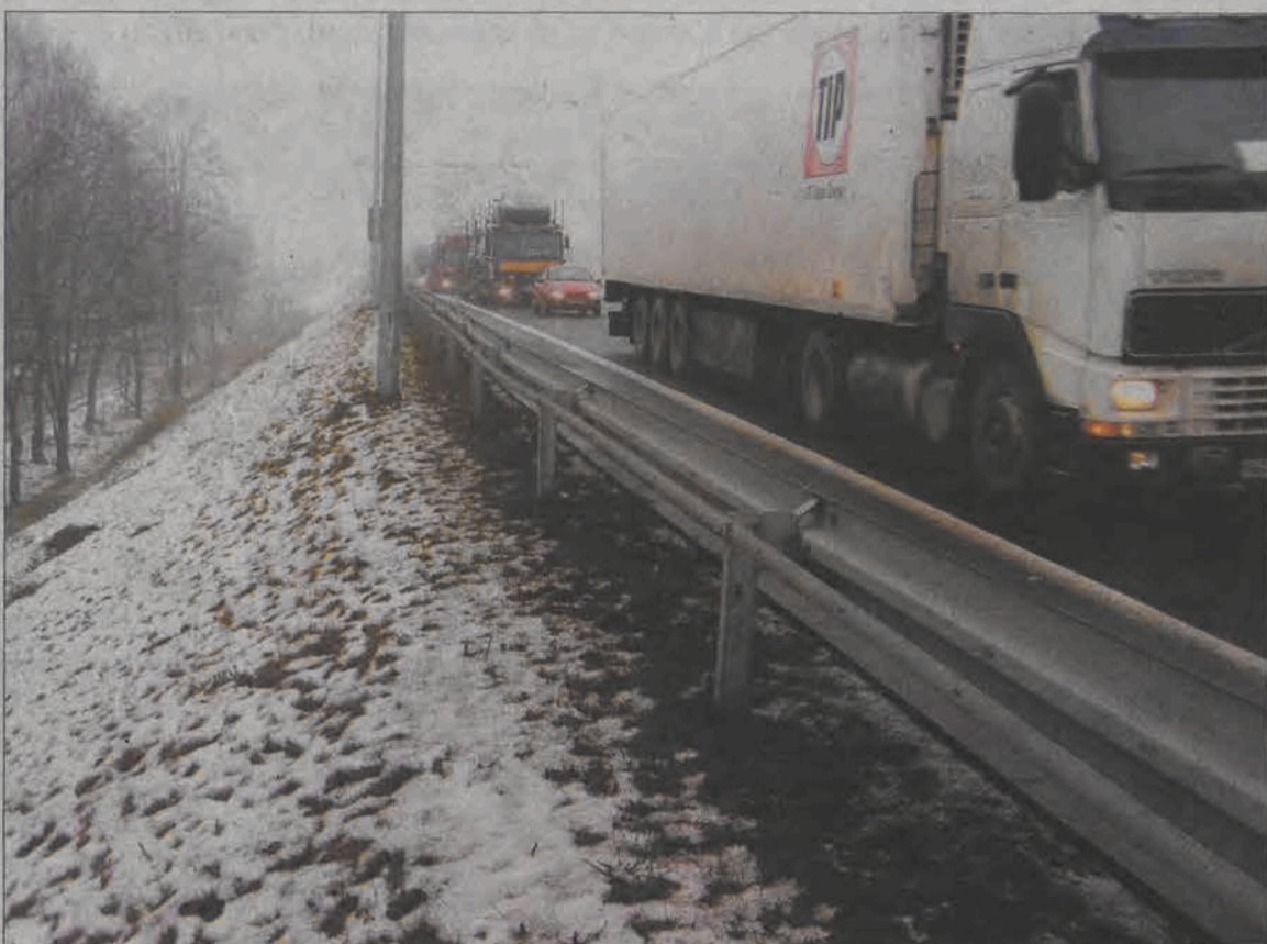
Według urzędników z Generalnej Dyrekcji Dróg Krajowych i Autostrad w Łodzi na wiadukcie nie ma miejsca na ekrany dźwiękochłonne. Gołym okiem widać, że takie miejsce jest.
