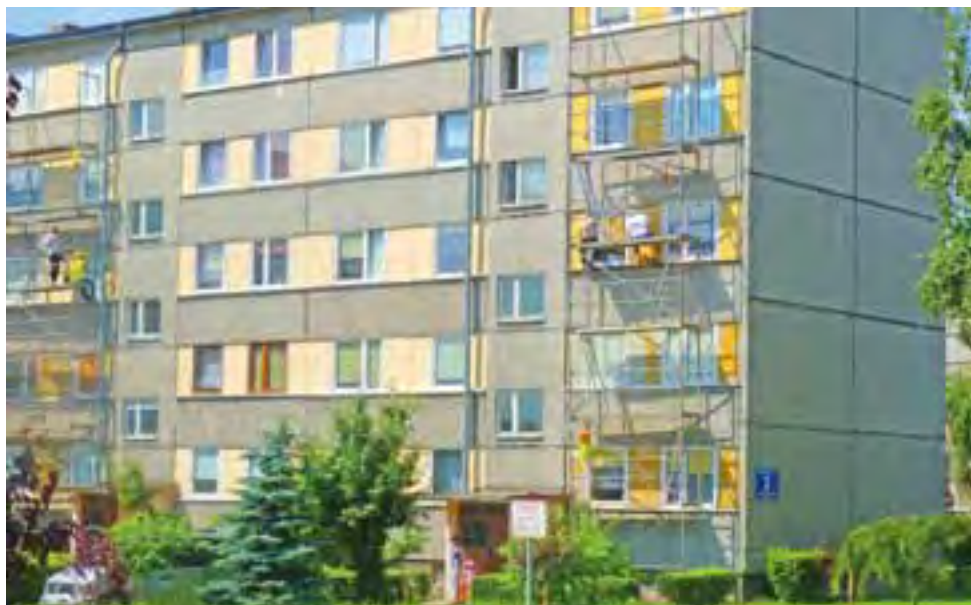
Podczas oczyszczania azbestowych powierzchni na blokach z wielkiej płyty przy ulicy Traugutta 1 w powietrze wzbija się chmura pyłu z włóknami azbestowymi.
