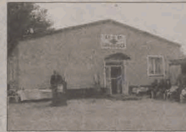
Stary magazyn został zamieniony w nowoczesną remizę strażacką.
