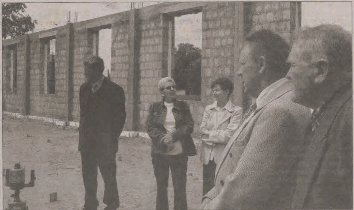
Radni gminy Głowno na placu budowy sali gimnastycznej w Mąkolicach.
