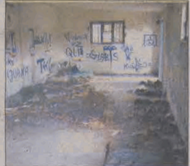
Pomieszczenie gospodarcze sąsiadujące z basztą według Andrzeja Biernackiego ilustruje stan, w jakim fundacja przejęła basztę.
