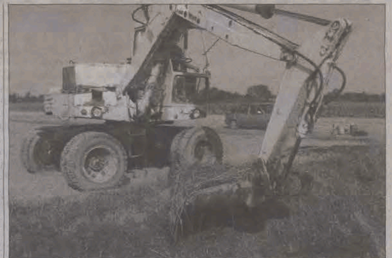
Mechaniczne odmulanie rowu w Woli Zbrożkowej potrwa do końca sierpnia.
