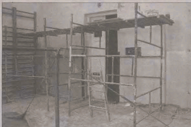
Remont małej sali gimnastycznej w ZSP 1 trwa.
