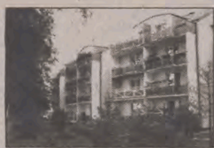
Mieszkańcy tego bloku wspólnymi siłami wybudują kotłownię.
