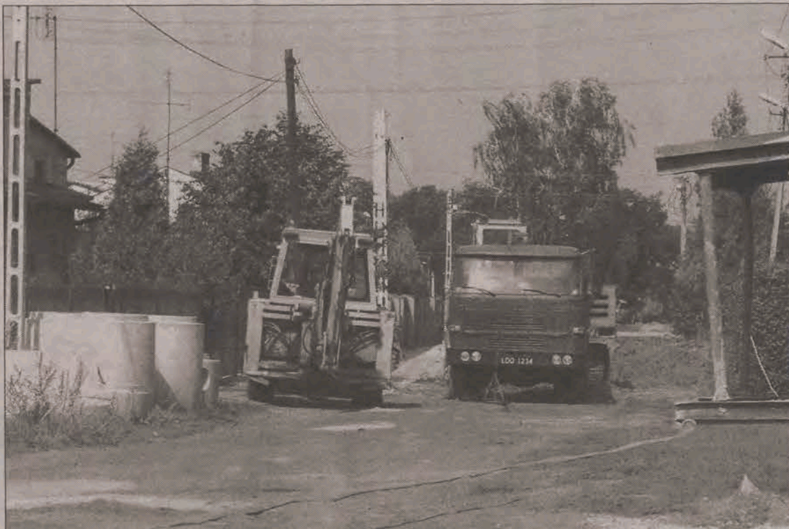
Do inwestycji jeszcze niezakończonych należy budowa kanalizacji pod ul. Prawą. Prace trwają, a prowadzi je głownieńska firma „Wodociągi i Kanalizacje” Krzysztofa Kucińskiego.
