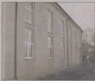
Sala gimnastyczna zyskała już pomarańczową elewację. Wewnątrz trwają prace wykończeniowe.
