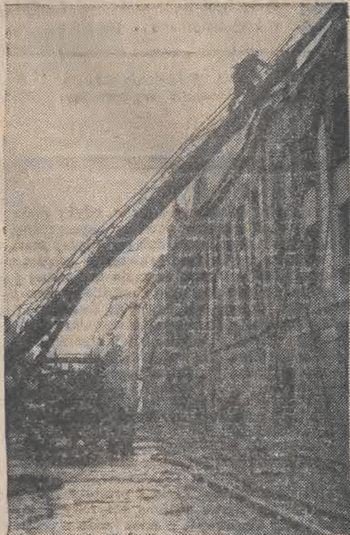
Do 1 października b. r. łódzka Straż Ogniowa musiała interweniować aż w 298 katastrofach budowlanych. Jak z tego wynika, katastrofy budowlane są w Łodzi znacznie większą plagą od pożarów. Dobrze, że strażacy nasi nie upierają się przy swej zasadniczej specjalności i spieszą ożarnie również na alarm: DOM SIĘ WALI!
