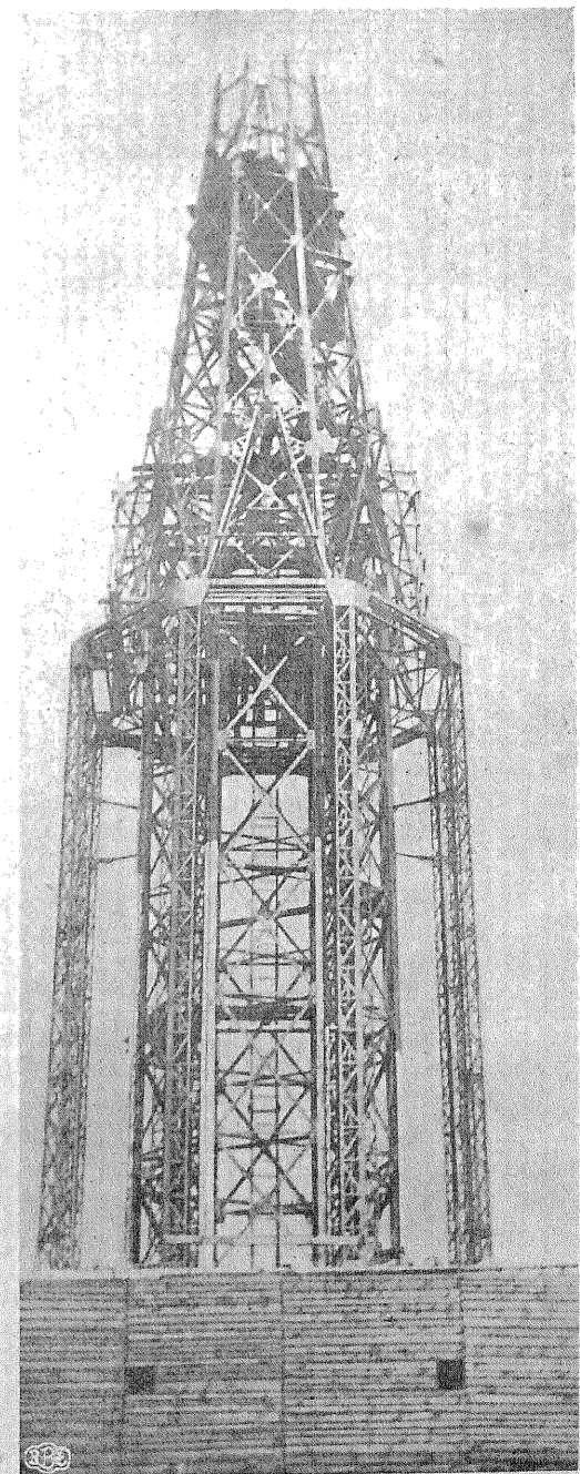
Nadbudowa wieży katedralnej w Łodzi. Ciekawe powiązania żelaznego szkieletu nadbudowywanej wieży.
