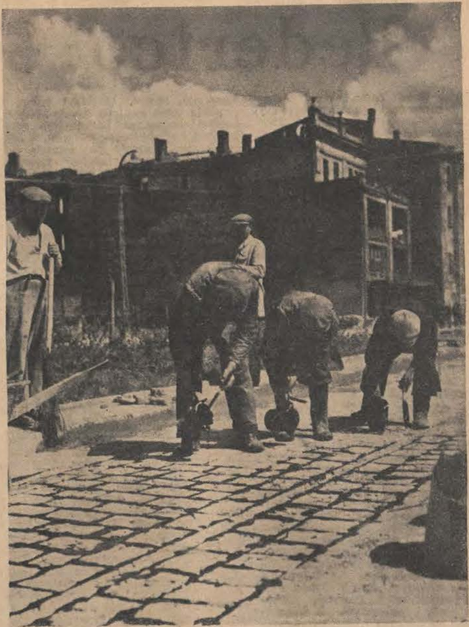
Prace brukarskie na Trasie W — Z.
