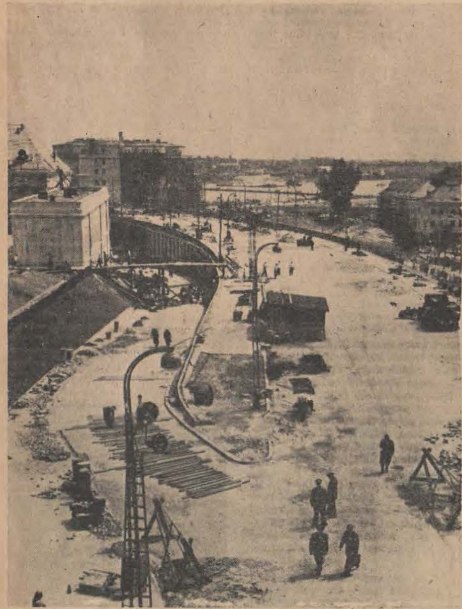
Wiadukt przed mostem Śląsko-Dąbrowskim.
