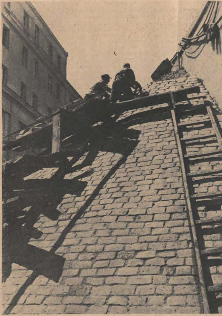
Prace na Trasie W — Z dobiegają końca.
