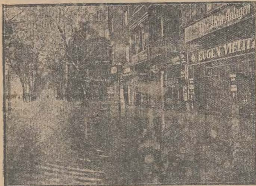
Links: Wasserrohrbruch verursacht riesige Überschwemmung.
