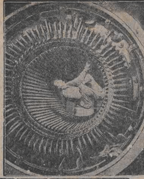
Der größte Turbo-Dynamo Europas wurde in dem neuen englischen Riesenkraftwerk Battersea aufgestellt. Die Dimension dieses Giganten, der 800 000 Kilowatt liefert, kann man aus der Größe des Monteurs, der im Innern des Dynamos arbeitet, ahnen.
