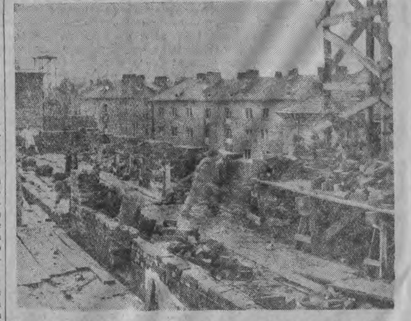
Białystok — miasto, które zostało bardzo zniszczone podczas wojny, odbudowuje się obecnie w szybkim tempie. Przy ulicy 1 Maja powstaje wielkie osiedle mieszkaniowe ZOR. Na zdjęciu: budowa domu osiedlowego; w głębi widoczne gotowe budynki. Foto-AR.
