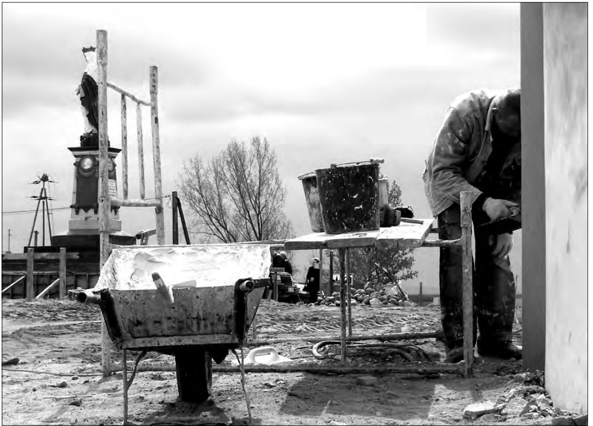
Nowe ogrodzenie harmonizuje z bryłą kościoła.
