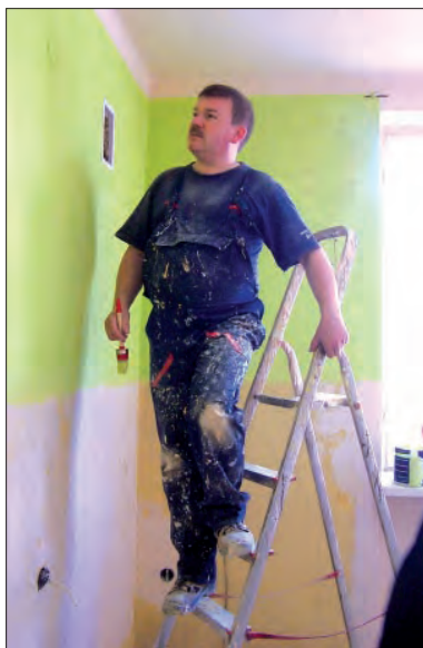
Remont pracowni trwał do 20 kwietnia.
