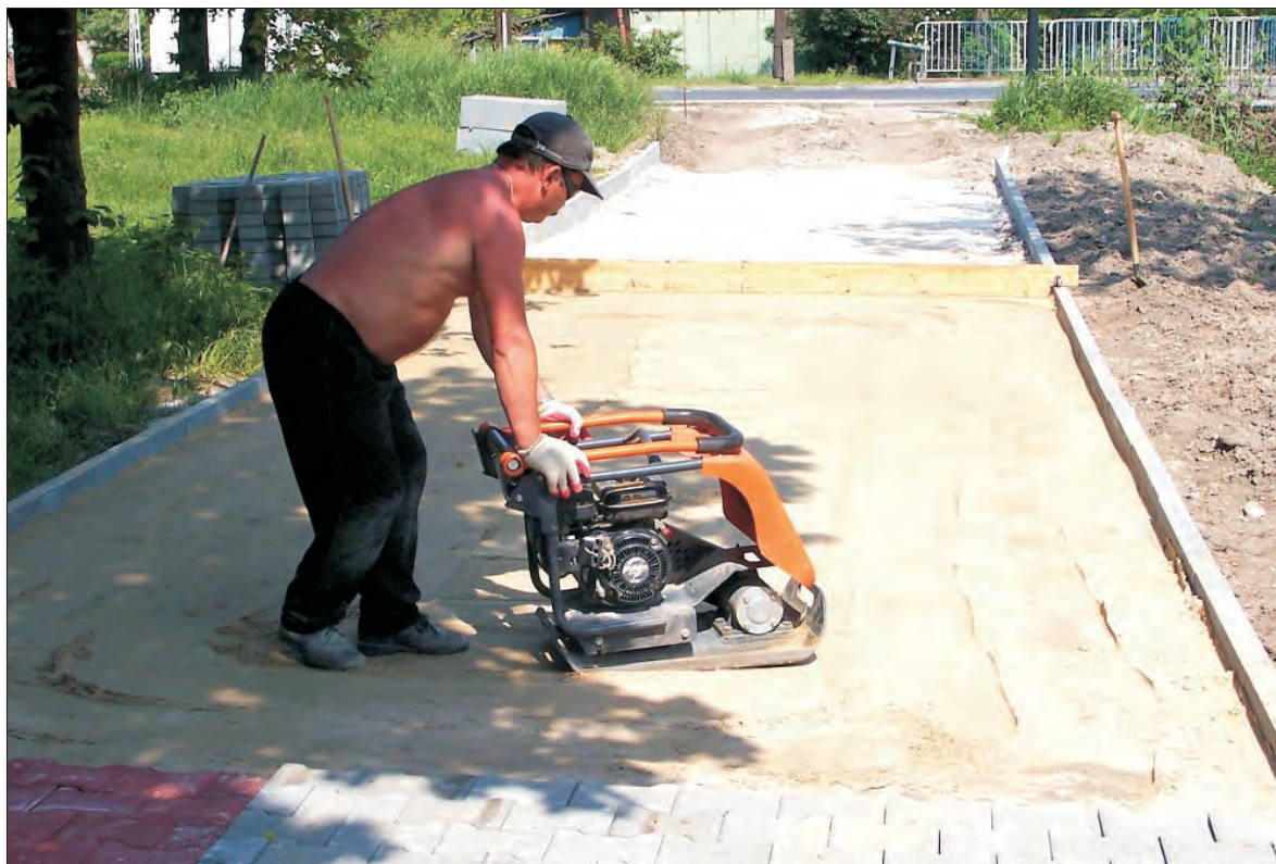
W piątek, 25 maja w godzinach przedpołudniowych ubijano jeszcze piaskową podbudowę chodnika.
