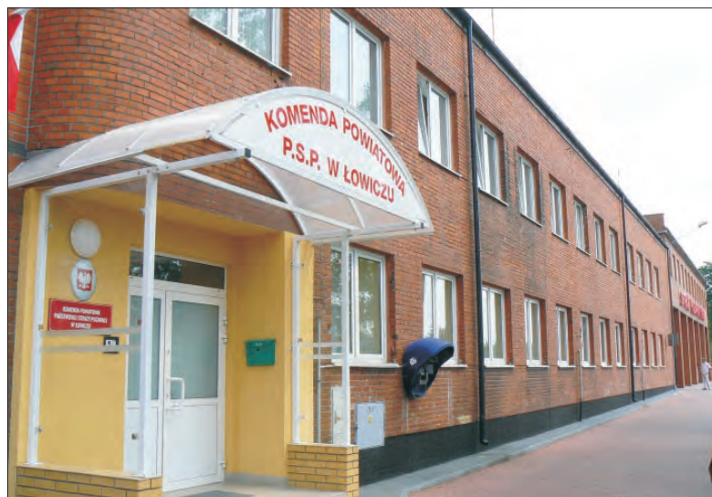
Strażnica jednostki PSP w Łowiczu przy ul. Seminaryjnej, remontowana systematycznie kilkanaście lat, została poświęcona w minioną niedzielę.
