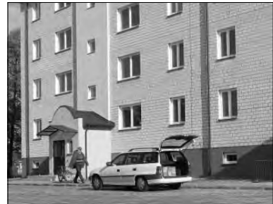
Dzięki wybudowaniu bloków komunalnych na Czajkach Ratusz dysponuje większą ilością mieszkań.
