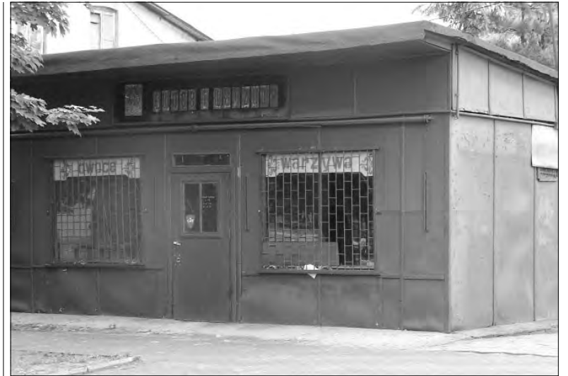
Mieszkańcy Głowna pamiętają, że niedawno w budynku tym mieścił się sklep warzywno-owocowy.
