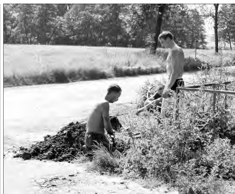
Światłowód w Karnkowie. Do końca czerwca pracownicy firmy TELEBUD powinni zakończyć zakładanie światłowodu w Karnkowie. Inwestycję w porozumieniu z gminą realizuje Telekomunikacja Polska S.A. Światłowód powstaje niezależnie od projektu budowy szerokopasmowego dostępu do internetu na terenie gminy Głowno, ale najprawdopodobniej zostanie z nim połączony i będzie stanowił element sieci, która docelowo oplecie całą gminę. (ew)
