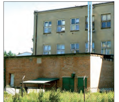
Nowa kotłownia opalana ekogroszkiem ma wyeliminować z użycia kotłownię olejową zlokalizowaną przy dawnej siedzibie SP2.
