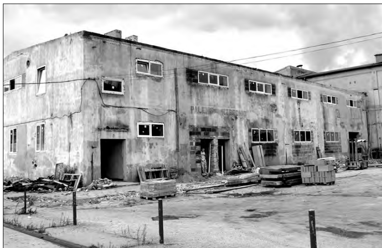
Remontowany obecnie budynek, w którym będzie mieściła się hurtownia materiałów budowlanych i do wykańczania wnętrz.
