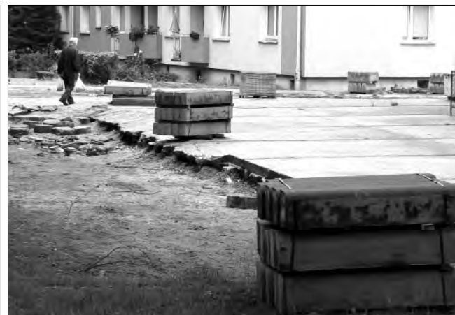
CHODNIKI NA OSIEDLU REYMONTA w Łowiczu kończy układanie brygada remontowo-budowlana ŁSM. Aktualnie trwają prace przed blokiem nr 3, a potem mają być dokończone chodniki pomiędzy blokami 2 i 3. W dalszej kolejności uporządkowany będzie plac, na którym kiedyś magazynowany był węgiel dla osiedlowej kotłowni. Teraz ma tam zostać zorganizowany parking dla mieszkańców. (mak)
