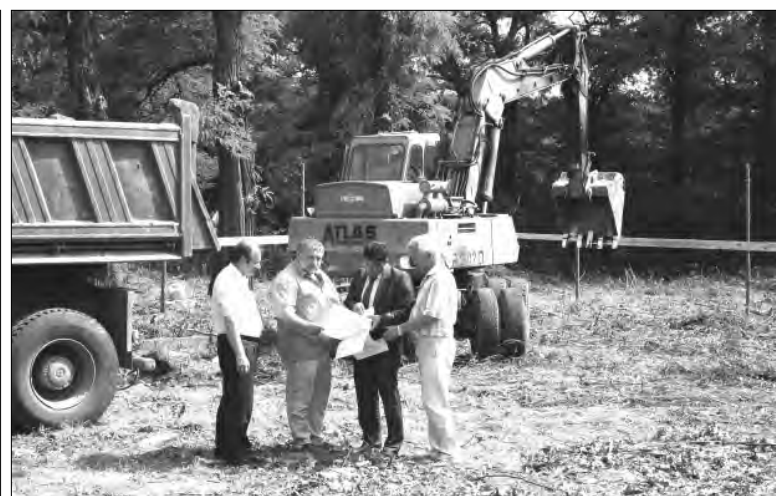
Na plac budowy bloku TBS wjechał sprzęt do robót ziemnych.
