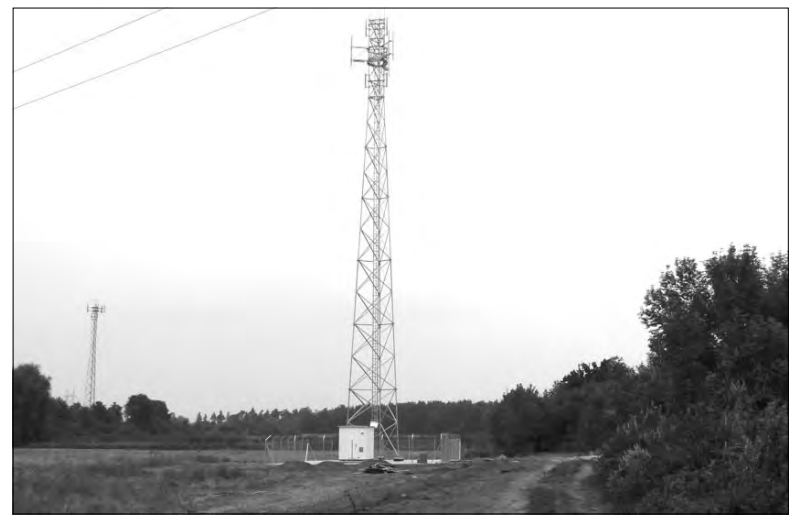
Maszt telefonii komórkowej Era GSM będzie przynosił właścicielowi działki miesięczny przychód 700 zł.
