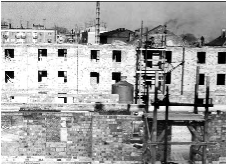
Osiedle Reymonta - tak powstawało.
