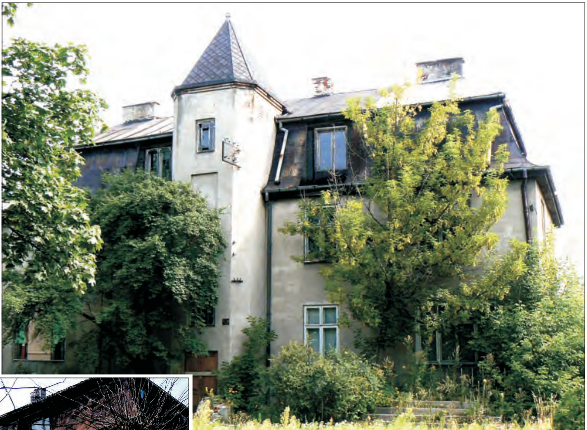
Zachodnią, frontową ścianą domu porastają dziś bujne zarośla. Ale nawet zaniedbany, skazany na rozbiórke budynek wciąż wygląda malowniczo.
