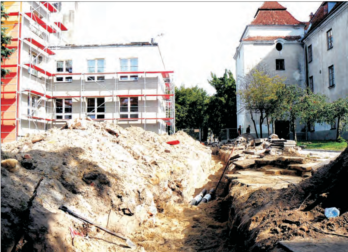
W tym wykopie, pomiędzy dawnym klasztorze a Szkołą Podstawową nr 4, znaleziono szczątki pięciu osób.
