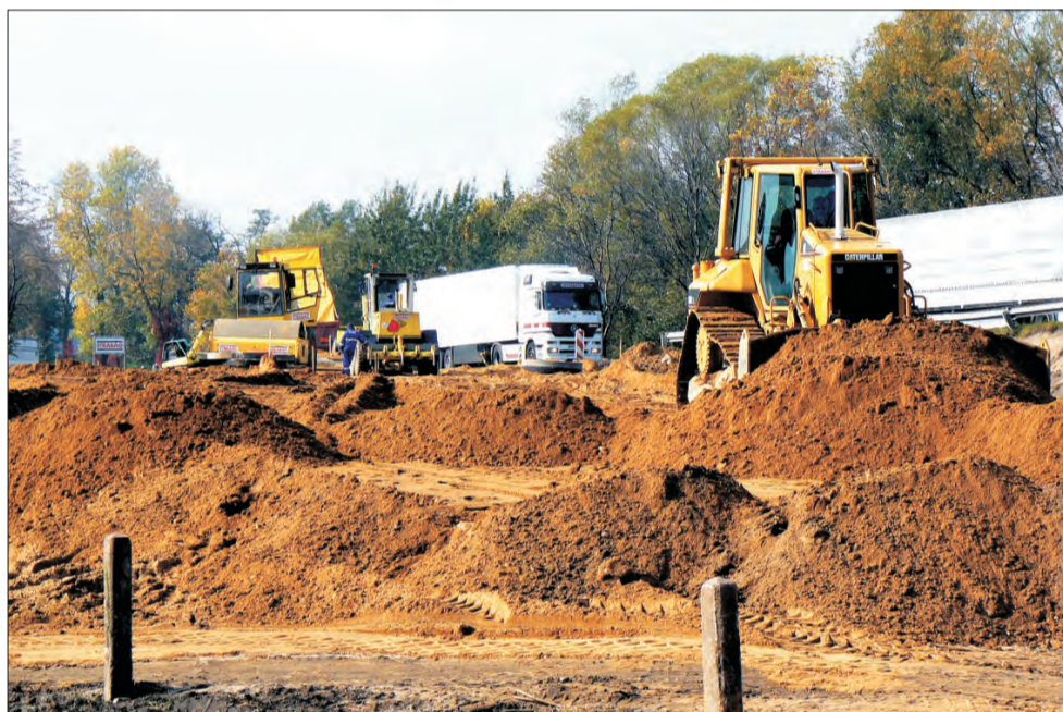
Prace przy wykonaniu objazdu wiaduktu na ul. Poznańskiej ruszyły pełną parą - nawieziono góry ziemi, na których zostanie ułożona tymczasowa nawierzchnia.
