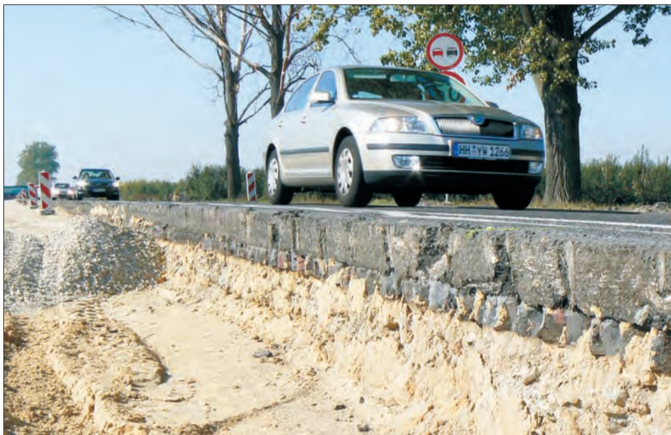
Przy tak słabej, starej podbudowie koleiny ma „dwójce” musiały się tworzyć. Budowa nowej, przy ciągłym ruchu, wymaga maksymalnej uwagi i od robotników, i od kierowców.
