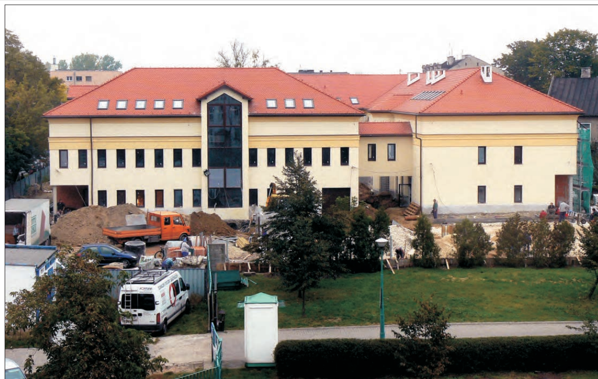
Elewacja południowej strony nowego budynku łowickiego sądu niemal w pełnej krasie.
