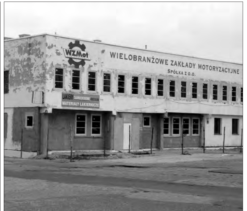
Nowe okna, częściowo już nowy tynk - to widoczne oznaki trwającej od sierpnia adaptacji nowego komisariatu.
