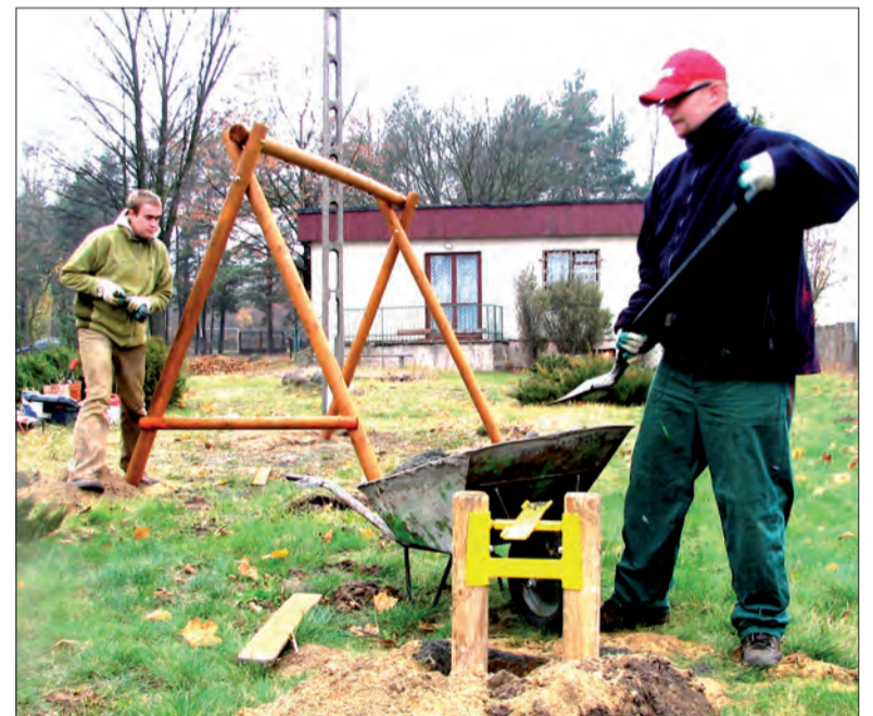
Plac zabaw przy szkole w Jamnie został zamontowany w ciągu jednego dnia, 6 listopada.
