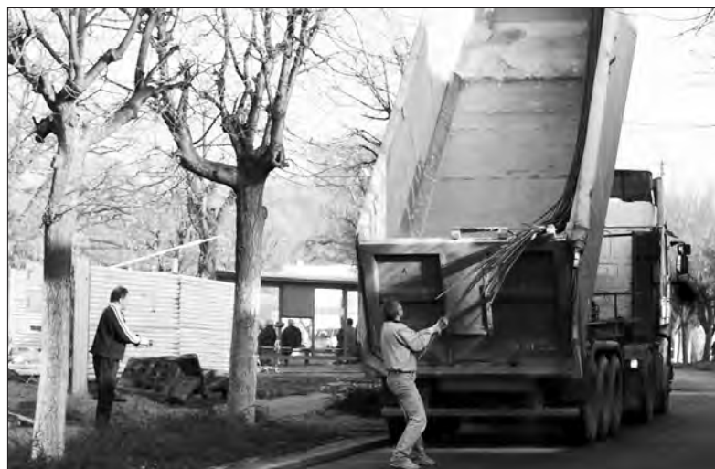
Remont na placu Wolności. Trwają prace związane z przebudową jezdni na placu Wolności w Głownie. W miniony czwartek na miejsce robót przywieziono metalowe pręty. Ich przeładunek okazał się dla robotników sprawą dość skomplikowaną, kiedy w pewnym momencie ładunek zsunął się z podniesionej skrzyni ciężarowej Scanii (ewr)
