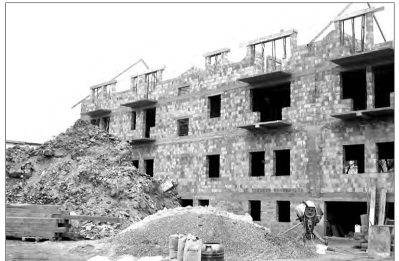
Widok budowanej kamienicy przy Placu Wolności 17 od strony podwórka.
