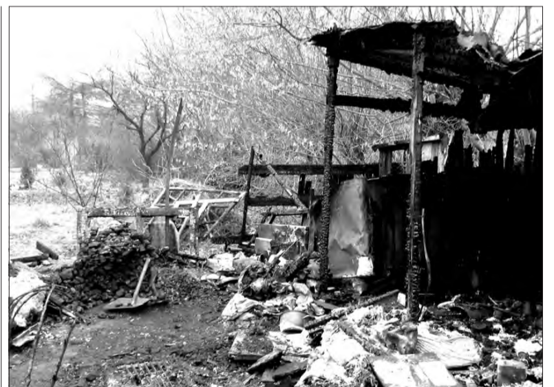
Tyle pozostało po pożarze altany na terenie ogródków działkowych „Mroga”.
