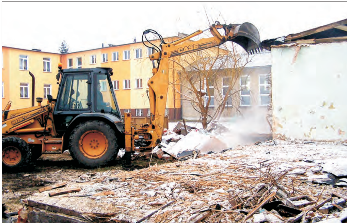
RUNĄŁ BARAK KOMUNALNY PRZY „TRÓJCE”. Niejeden powie „wreszcie”. W połowie minionego tygodnia rozpoczęły się kilkakrotnie już zapowiadane prace rozbiórkowe budynku komunalnego przy ul. Karasickiej w Głownie, położonego na terenie Szkoły Podstawowej nr 3. O jego zlikwidowanie od wielu już lat zabiegali m.in. dyrekcja szkoły, ale nie było to możliwe, bo był on jeszcze do niedawna zamieszkiwany przez dwie lokatorki. W tym roku udało się jednak znaleźć dla nich inne mieszkania komunalne i rozbiórka okazała się możliwa. (ljs)
