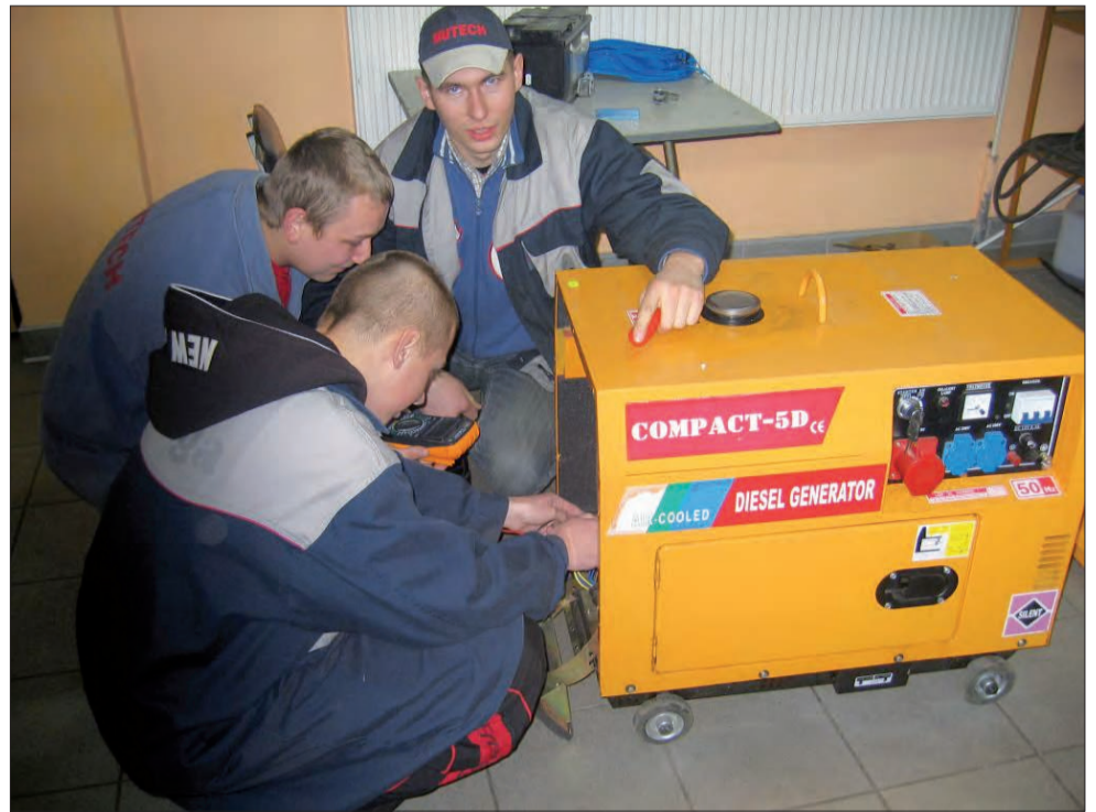
Nauka obsługi generatora prądowłórczego na olej napędowy.
