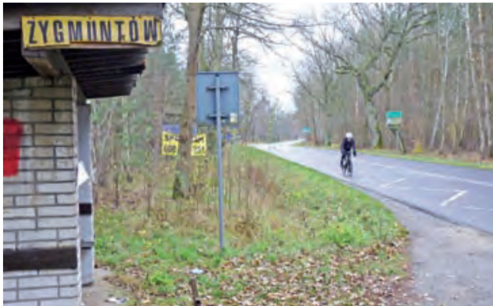
Przeszło 600 tys. zł gmina Nieborów wyda w tym roku na budowę ścieżki rowerowej wzdłuż starej siedemdziesiątki od zajazdu Rozdroże do przystanku autobusowego Zygmuntołów.
