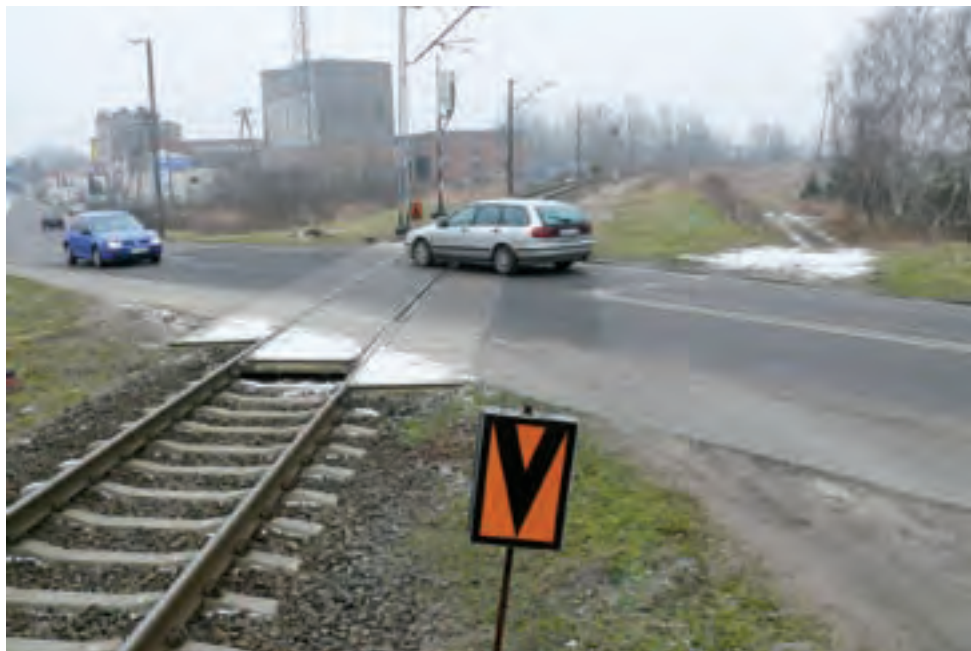
Tory, jak i przejazd kolejowy w ul. Klickiego, zostaną przesunięte o 40 m na wschód, wówczas powstanie miejsce, w którym mogłoby się zmieścić skrzyżowanie z nową drogą (na zdjęciu po drugiej stronie ulicy).
