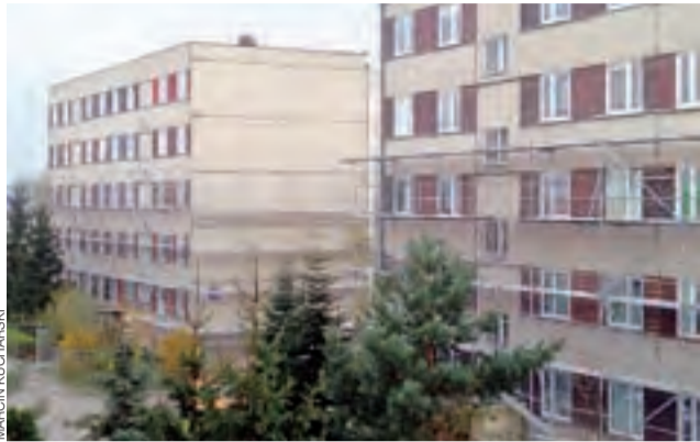
Bloki nr 39 i 40 na osiedlu Bratkowice w Łowiczu.
