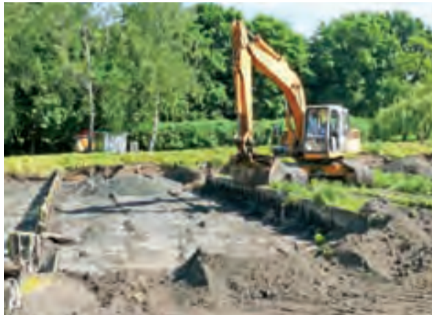
Koparka pracująca w boksach, w których gromadzone były osady. Obecnie są one rozbierane, ponieważ teren ten zmieni przeznaczenie.
