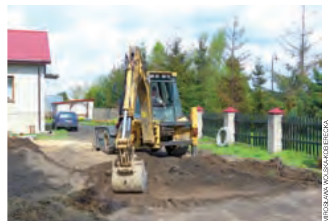
Jedna z ekip z Cewogazu prowadzi prace w Szymanowicach, na terenie prywatnej posesji. Powstaje tu przepompownia ścieków i przyłącze.
