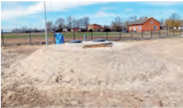
Leśniczówka. Nowa studnia głębinowa już zasila w wodę okoliczne wsie.
