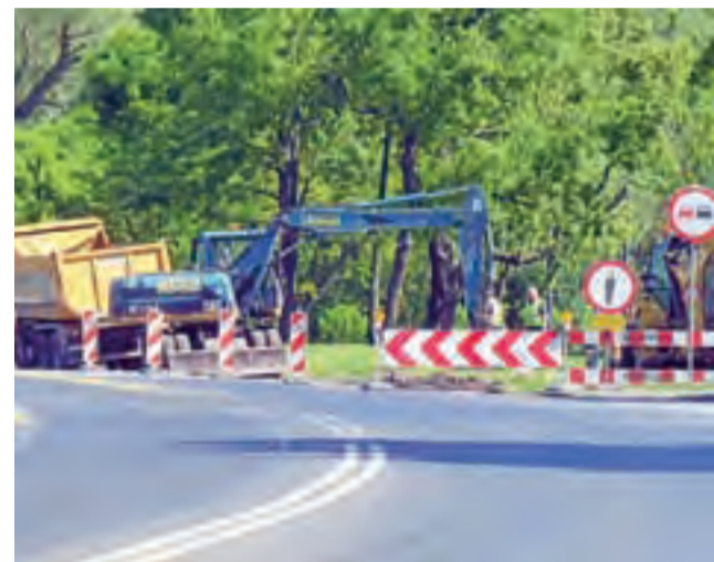
Roboty rozpoczęły się od budowy pasa włączenia do ruchu dla samochodów, które wyjadą z u. Świętojańskiej.
