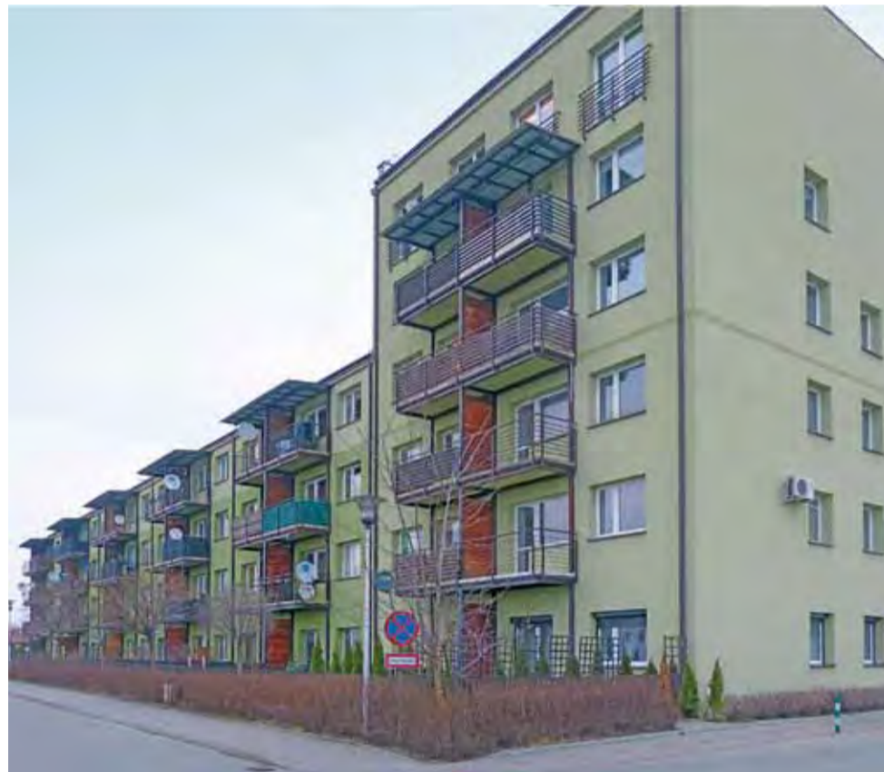
Blok przy ul. Piekarskiej 4. Członkowie wspólnoty z własnych kieszeni musieli pokryć m.in. koszty naprawy ocieplenia ściany szczytowej.
