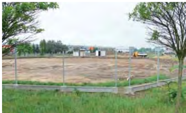
Skład budowlany powstanie po prawej stronie ulicy Uchanka, patrząc w kierunku zakładu Baumit, obecnie z ronda widać już wykorytowaną powierzchnię przygotowaną pod przyjęcie podbudowy.
