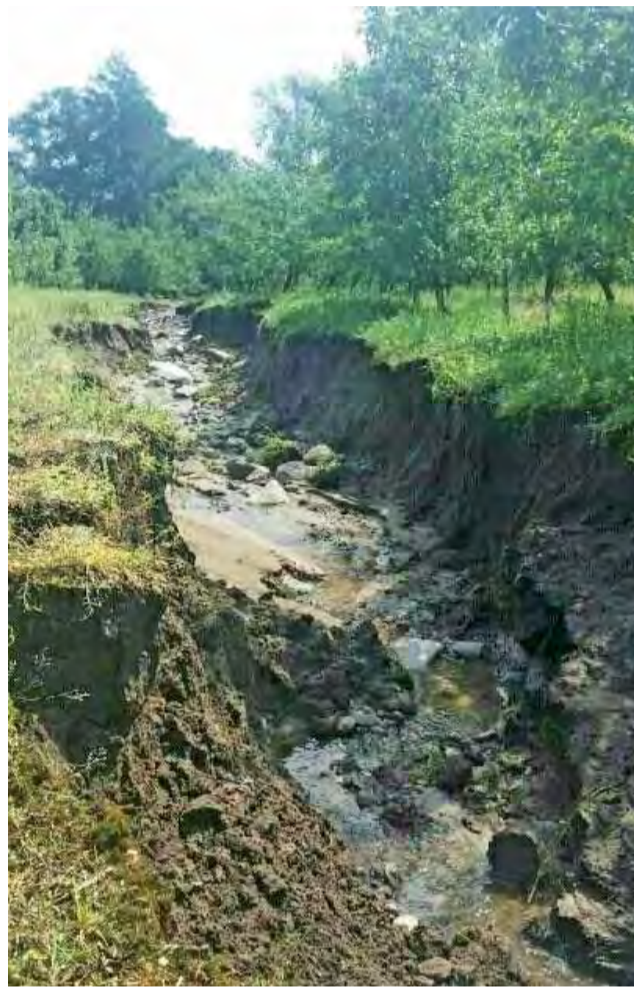
Tak po ulewie wygląda dawny, dość płytki rów odprowadzający wodę z pól, spływająca nim woda pogłębiła go do ponad 1,5 m.
