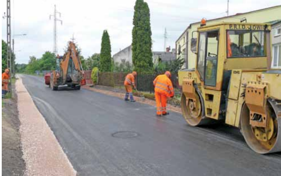
Ostatnie prace przy budowie nawierzchni na ul. Sochaczewskiej.
