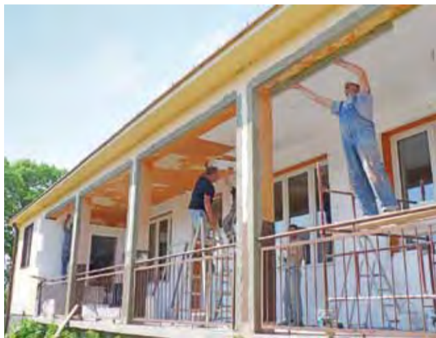
Trwają prace przy remoncie tarasu.
