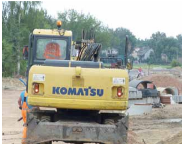
Budowa ulicy Dmowskiego wciąż postępuje do przodu.
